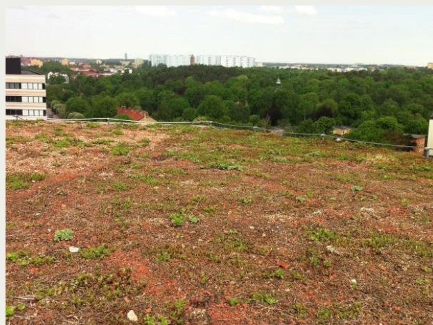
Figur 1. KI-aulan i Stockholm är försett med ett sedumtak. Huvudmotivet till att välja grönt tak var att utjämna belastningen på dagvattennätet i samband med kraftiga regn. Foto: Eva Sikander
